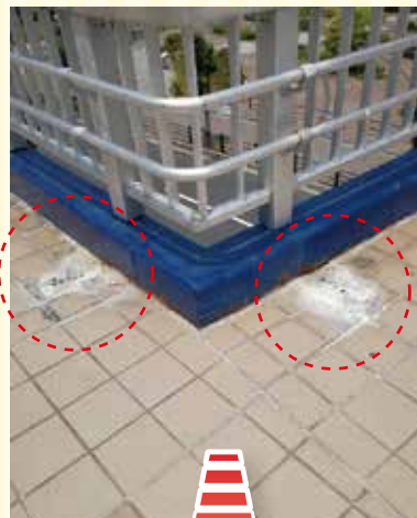
歩道橋の排水口掃除
