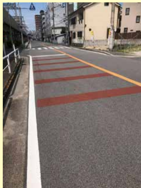
さつき学園近く、4車線にわたって横断歩道横に5線(茶色の凹凸のカラー舗装)を引く工事
