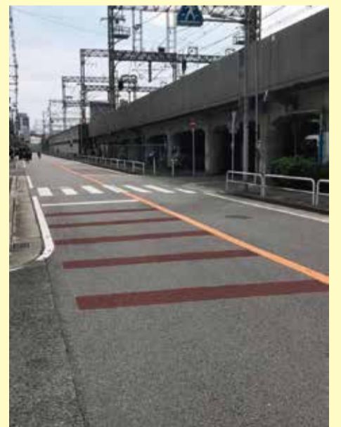
さつき学園近く、4車線にわたって横断歩道横に5線(茶色の凹凸のカラー舗装)を引く工事
